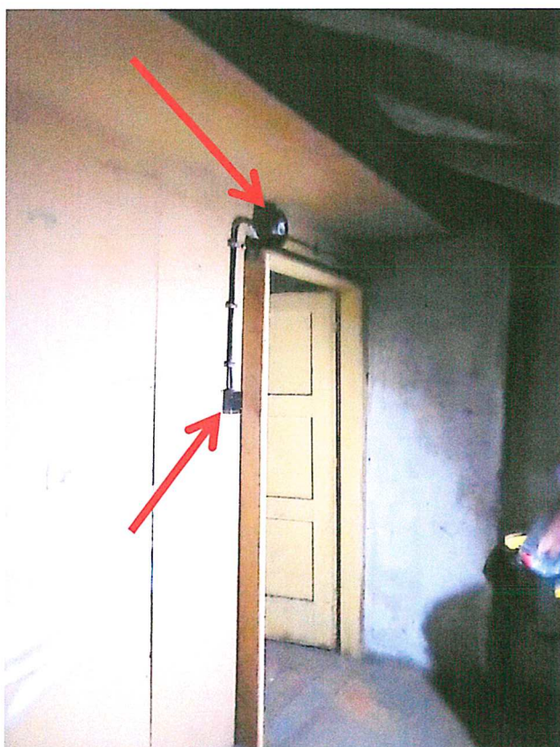
Foto č. 8 – Půdní prostor. Azbestové podložky pod vypínačem a svítlidem.
