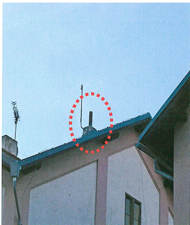
Foto č. 12 – Azbestocementová roura jako ukončení komínového průduchu.
