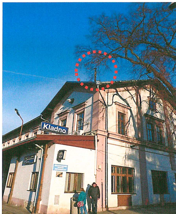
Foto č. 15 - Azbestocementová roura vystupující nad střešní plochu.
