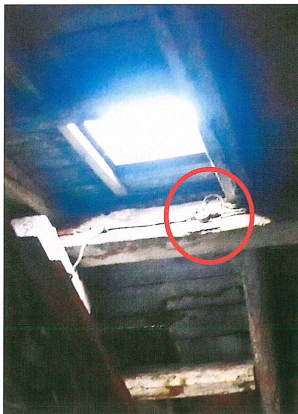
Foto č. 9 – Půdní prostor. Azbestová podložka pod rozvodnou krabicí.
