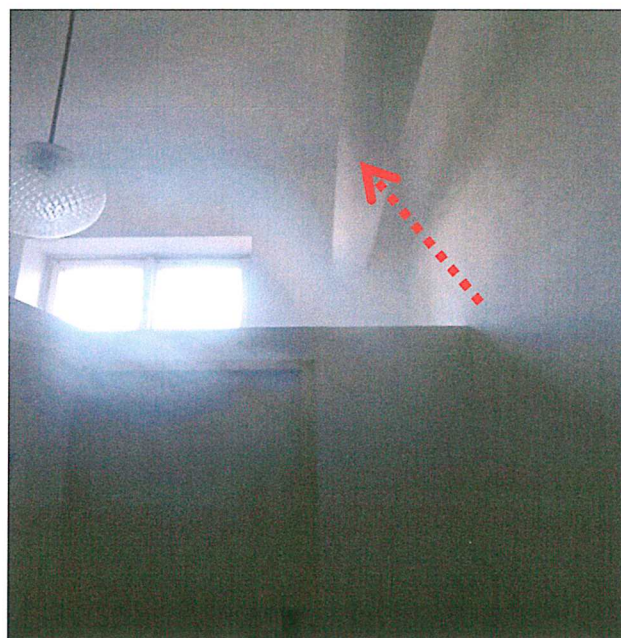
Foto č. 11 – 2.NP, WC muži. Azbestocementová roura použita k odvětrání prostor a ústící na fasádu objektu.
