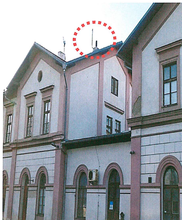
Foto č. 13 - Azbestocementová roura jako ukončení komínového průduchu.
