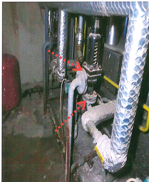
Foto č. 17 – Sklepní prostor, kotelna. Příruby tlakových potrubí těsněné plochými typy těsnění.
